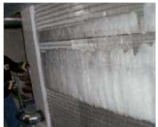
Abb. 3: Vereister Verdampfer. Nur noch ein Teil der Fläche wird von Luft durchströmt.
