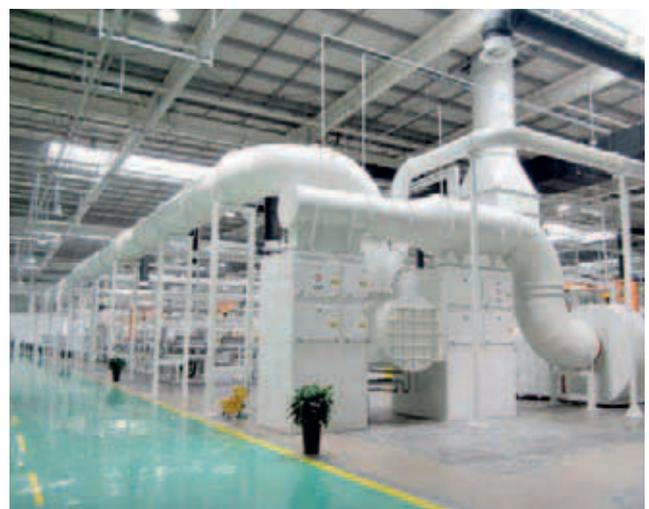
Bild 24 Zentral-Absauganlage
