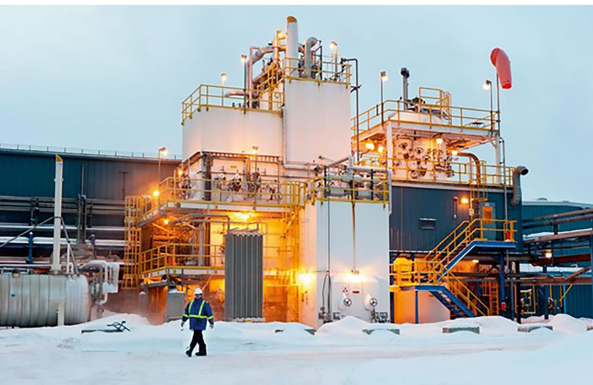
Mit der Anlage in Bécancour in Kanada wurde im Januar 2021 die weltweit größte Proton Exchange Membrane-Elektrolyseanlage mit einer Kapazität von 20 Megawatt in Betrieb genommen.
