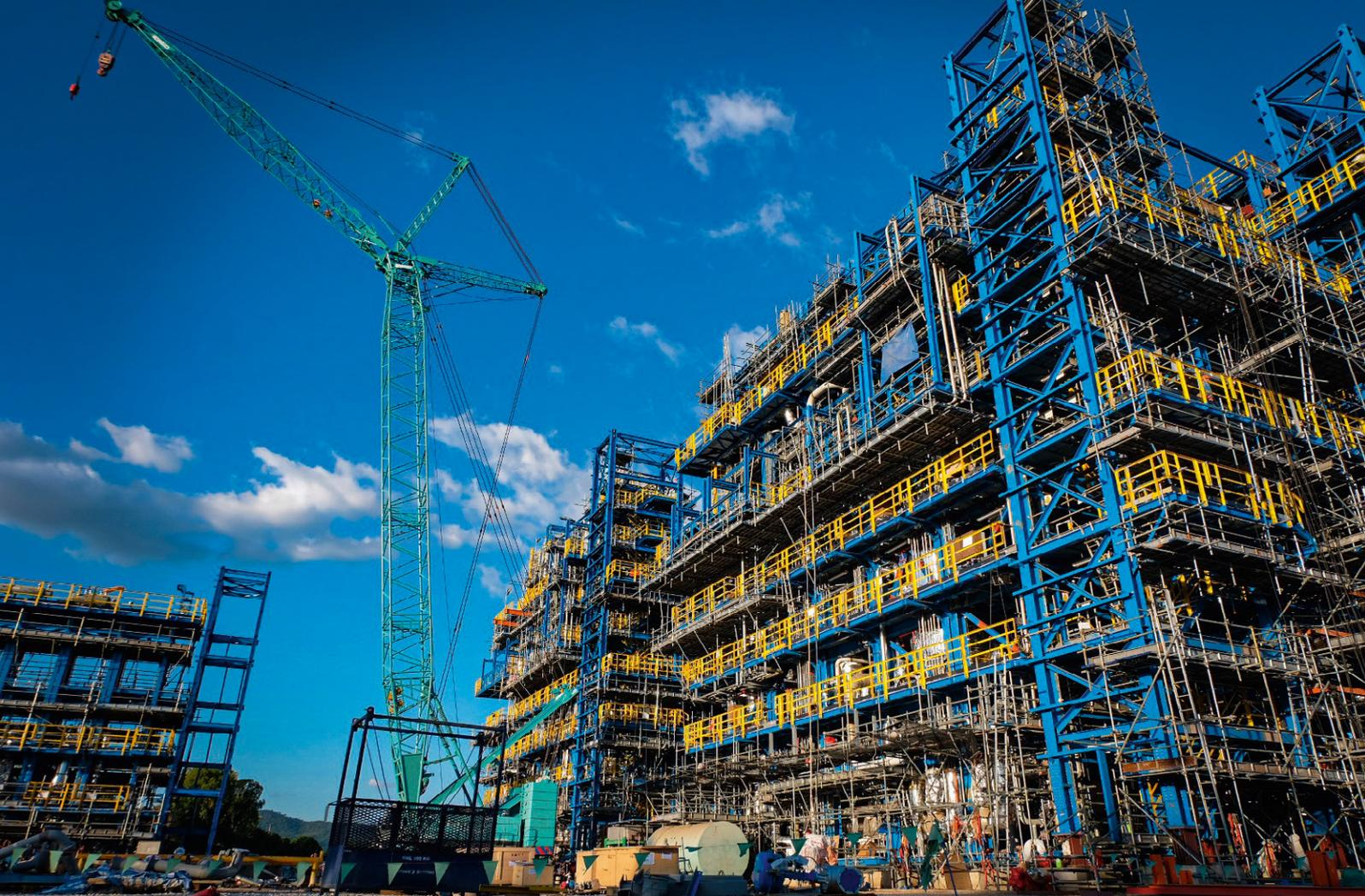
Ein wichtiger Hebel zur Kostensenkung und Produktivitätssteigerung im Großanlagenbau ist die Modularisierung und Vorfertigung von kompletten Anlagen, Baugruppen und Technologiemodulen.
